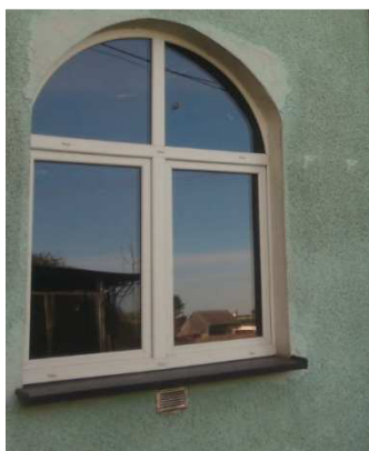
Zdj.: Kratki wywiewne w ścianie zewnętrznej świetlicy – od zewnątrz budynku.
