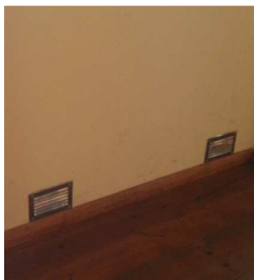
Zdj.: Kratki wywiewne w ścianie zewnętrznej świetlicy – od wewnątrz pomieszczenia.
