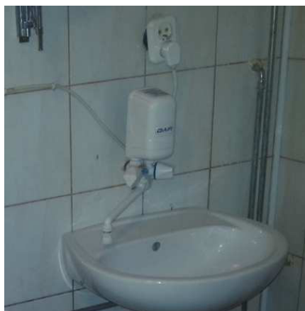
Zdj.: Elektryczny, przepływowy podgrzewacz wody.
