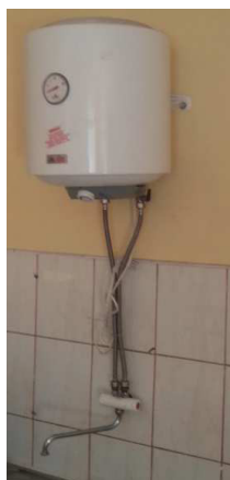
Zdj.: Elektryczny, pojemnościowy podgrzewacz wody.
