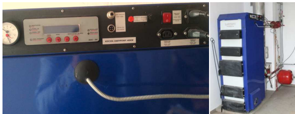
Zdj.: Kocioł na ekogroszek w pomieszczeniu kotłowni.
