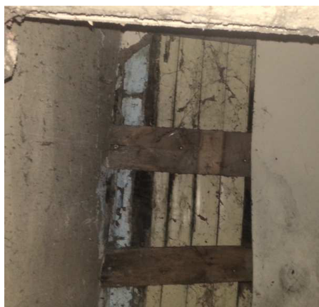
Zdj.: Fragment odsłoniętej konstrukcji dach (konstrukcja więzarowa).
